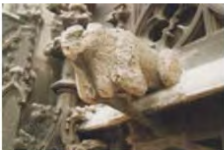
verwitterter Wasserspeicher
